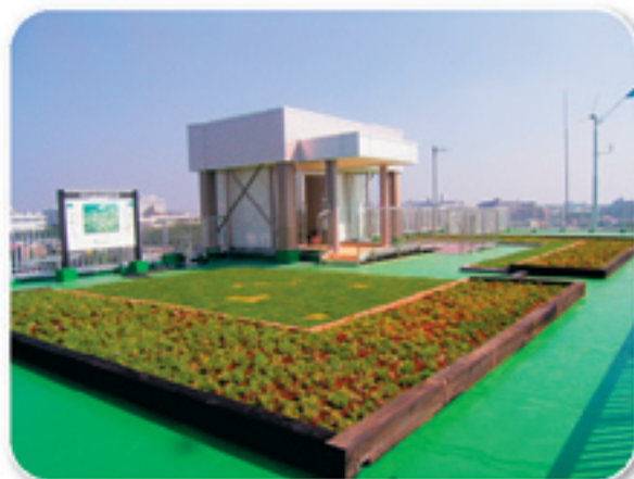
東村山浄水場高度棟
