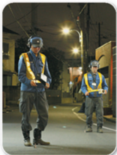
夜間の漏水発見作業
