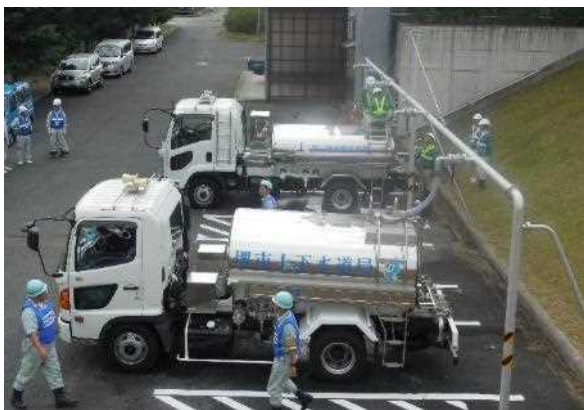
〔岡山市の複数設置された給水車用給水栓〕
