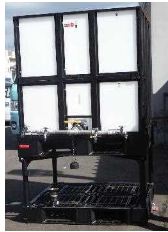
〔札幌市の仮設水槽〕
