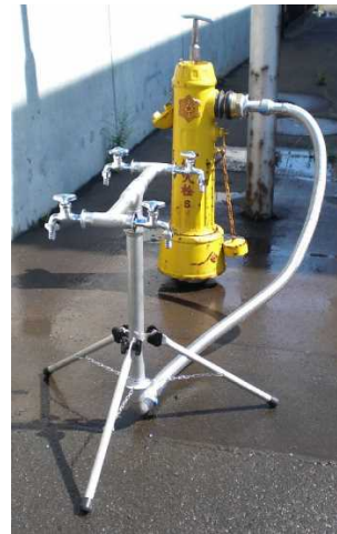
〔札幌市の事例（左：仮設給水栓運搬時、右：設置時）〕
