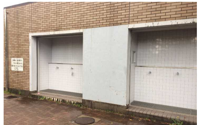
〔名古屋市事例 (平時はシャッター下ろして施錠)〕
