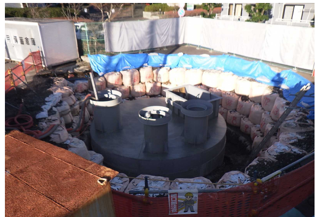
〔静岡市の事例（縦型）※工事中〕
