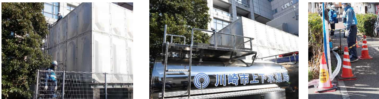
〔合同訓練事例（左、中：給水車から受水槽への給水、右：消火栓等からの給水）〕
