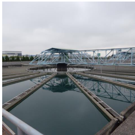
鯉魚潭浄水場
