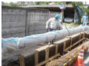
水道管の取替え工事
