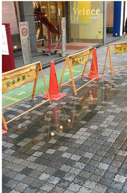
図14 給水管漏水
